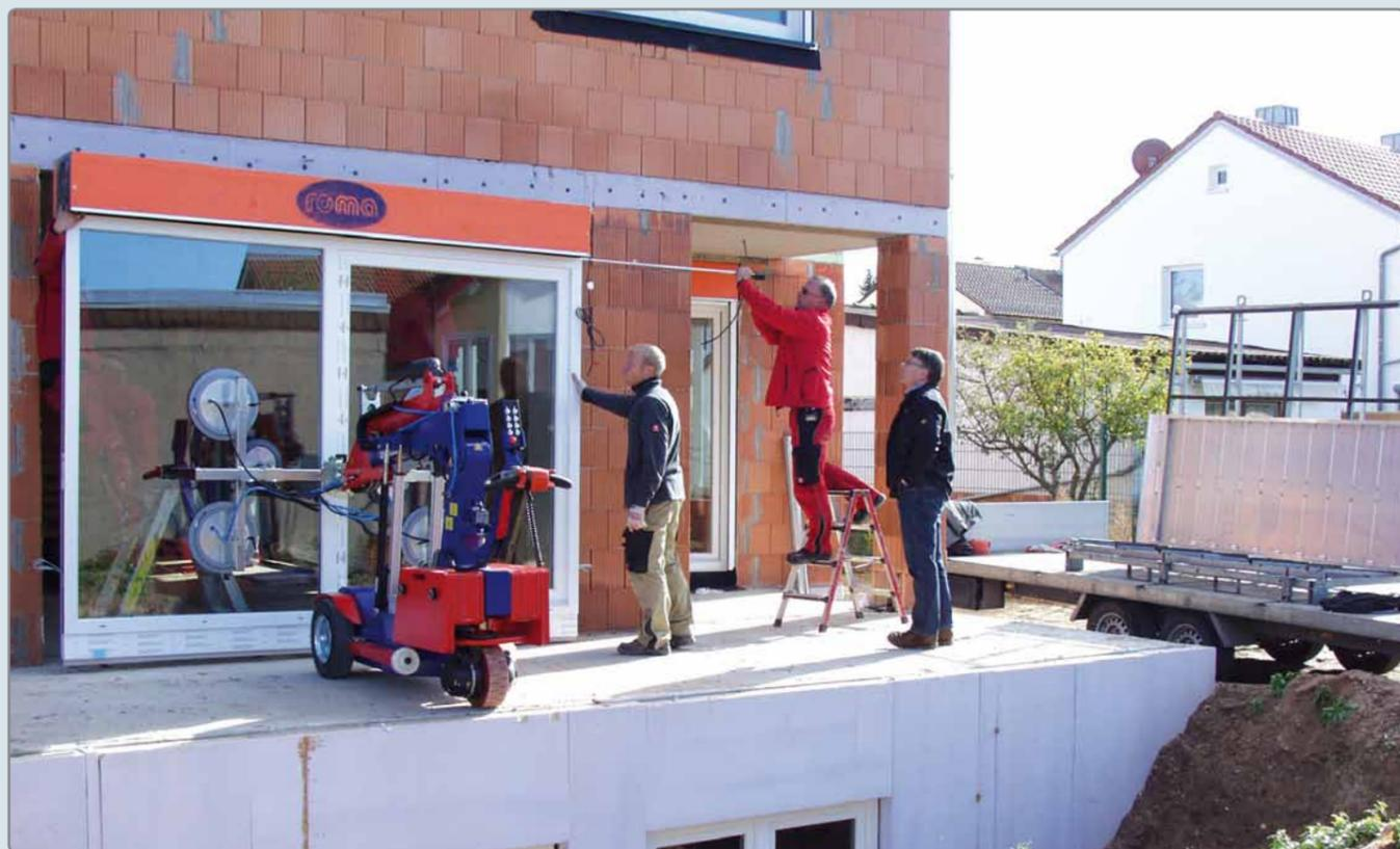
KS Robot lors de la pose d'une porte coulissante à levage.
