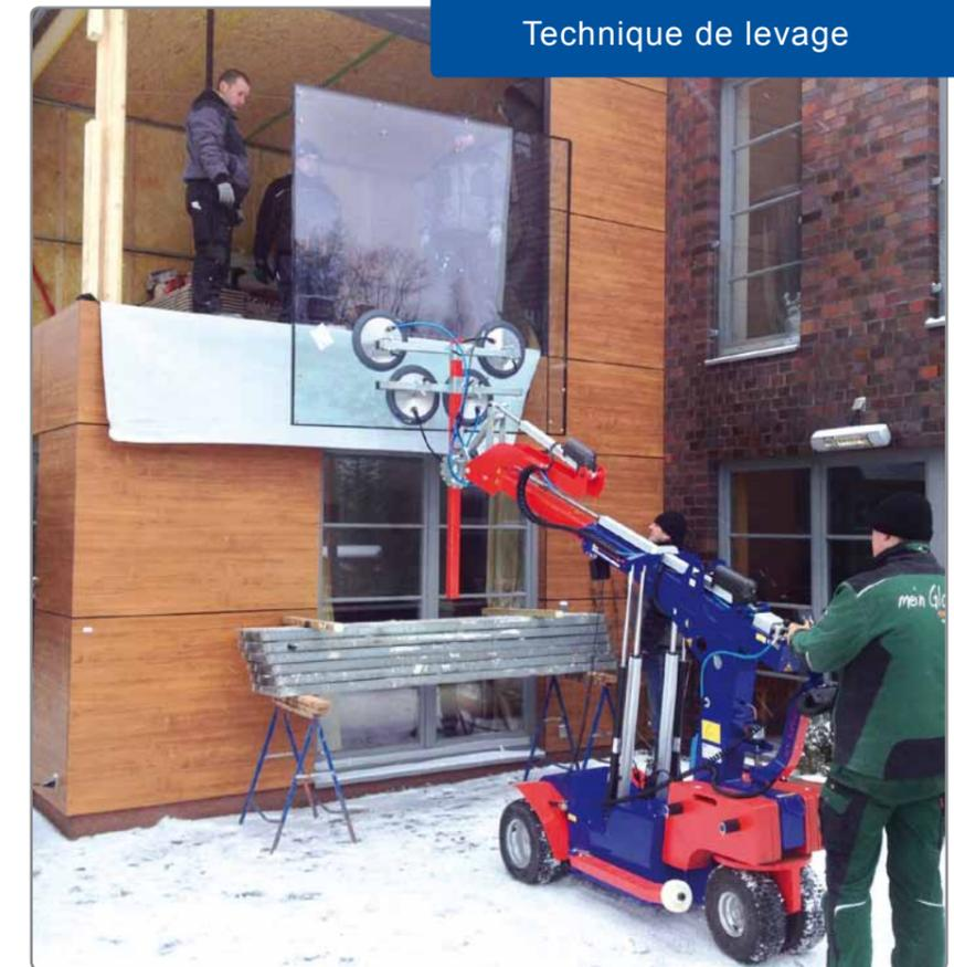
Commande synchronisée et démarrage de qualité veillent aux déroulements des mouvements tout en douceur et souplesse. Fig. KS 400 Offroad.
