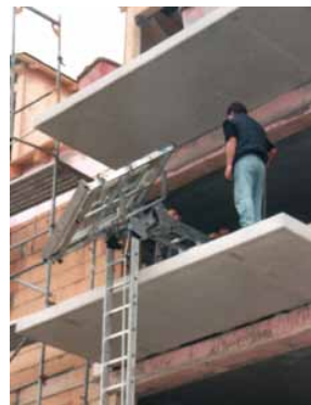
KS MAZ – Léve-vitres vertical, parallèle au mur de l'immeuble
