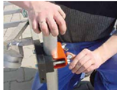
Les stabilisateurs latéraux sont fixés à l'aide d'écrous à ailettes
