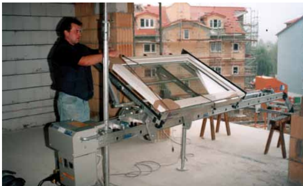
Les matériaux de construction sont levés verticalement puis transportés horizontalement dans la pièce ; ils peuvent ainsi être déchargés facilement
