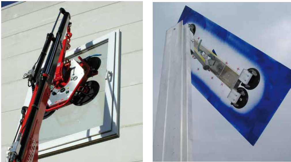
KS MultiCrawler Crane avec KS VacuPower 300 Table de réception de vitrage pour vitrage en toiture
