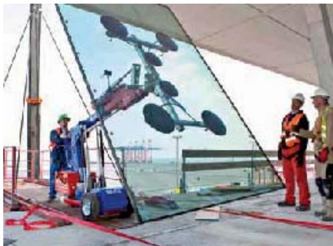
Ici, le KS Robot est utilisé pour vitrer des façades avec des vitrages pesant env. 500 kg.
