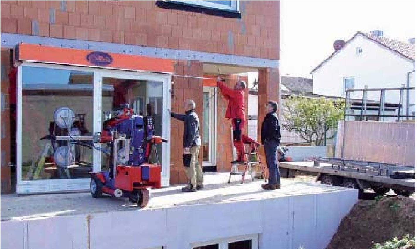
KS Robot 550 lors de la pose d'une porte coulissante à levage
