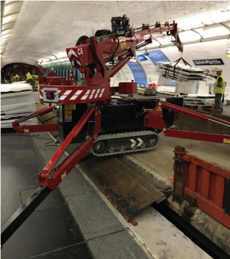
Déplacement hydraulique des contrepoids
