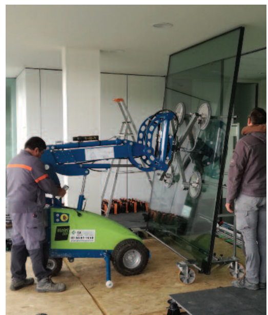
Chariot HDL avec robot de pose Winlet 600.
